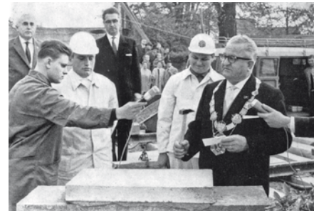
Oberbürgermeister Heinrich Völker bei der Grundsteinlegung am 19. Oktober 1963
