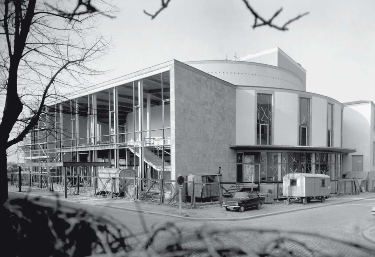
Das neue Spiel- und Festhaus kurz vor seiner Fertigstellung
